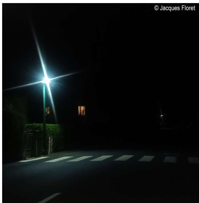
20 éclairages solaires à LED viennent d'être installés
