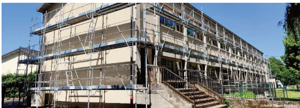
Les travaux continuent à l'école élémentaire Georges Pompidou
