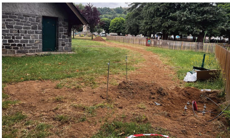
Des tranchées ont été creusées au Coudert afin d'installer l'éclairage.
