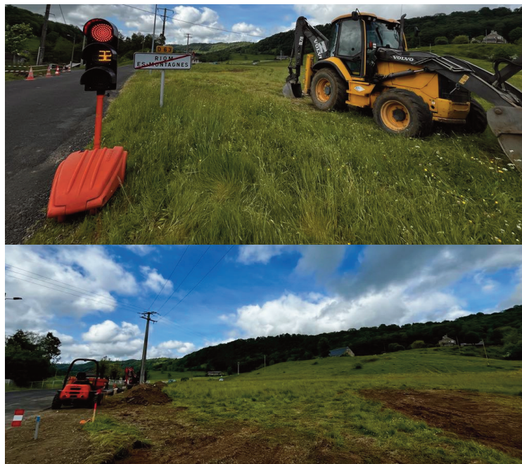
Les travaux débutent pour l'extension du lotissement de Saussac.
