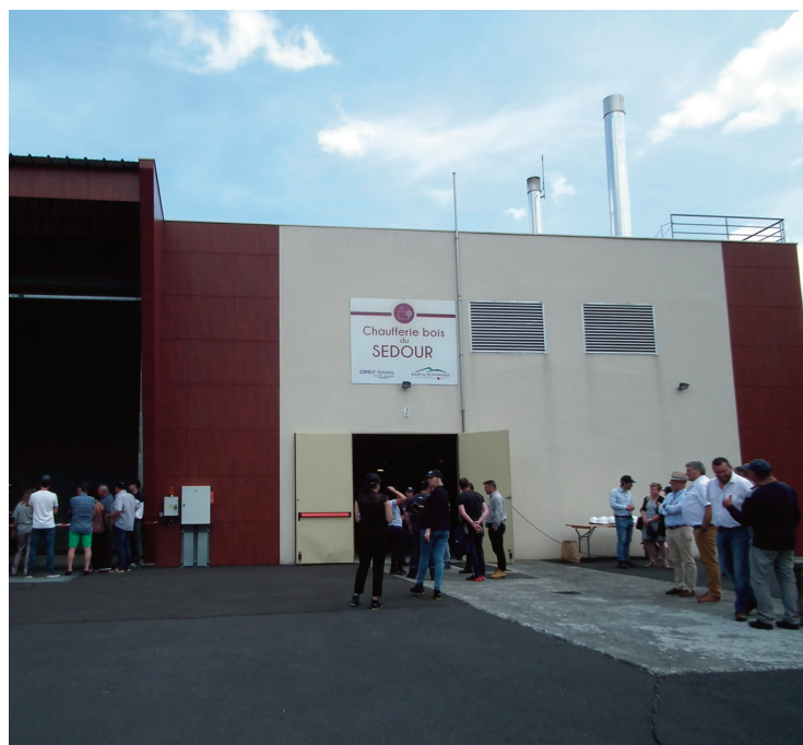
Sortie de terre en 2013, la chaufferie a déjà un bon bilan après 10 ans de fonctionnement.
